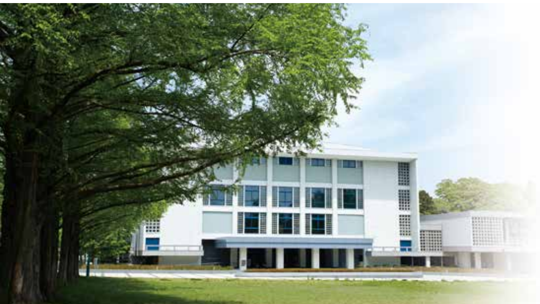
東北大学百周年記念会館川内萩ホール（川内南キャンパス）。50周年で建造された記念講堂のデザインを可能な限り保存、修復し、第一線級のコンサート専用ホールと同等の非常に高度な環境のコンサートホールの要素を加味した国際会議場である。
