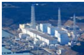
東京電力福島第一原子力発電所
